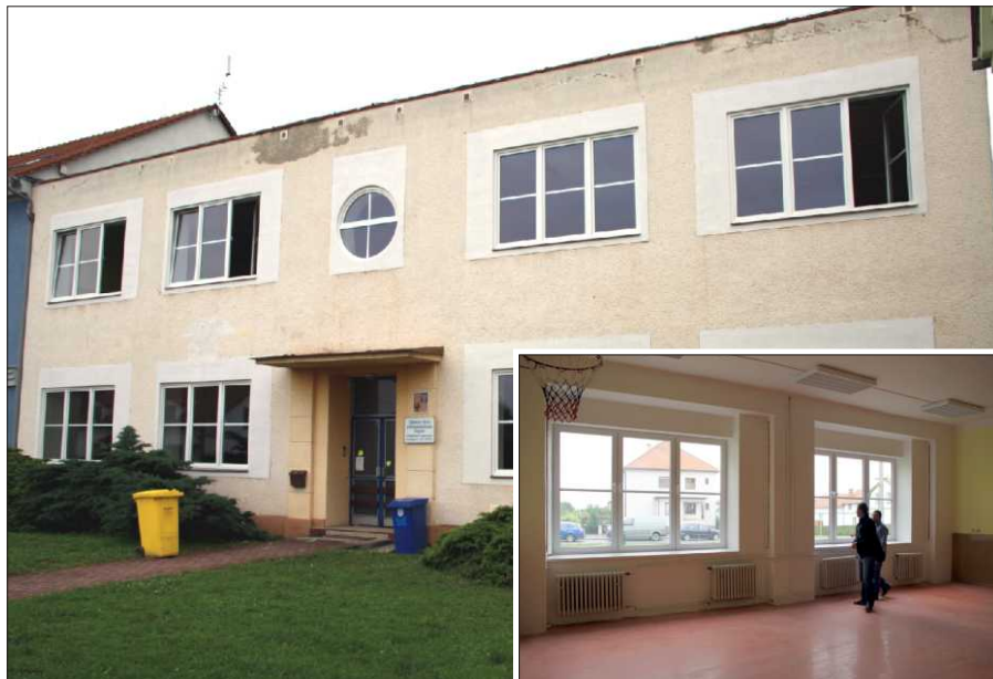
Základní škola v Grygově dostala nová okna. Ve výřezu pohled z tělocvičny.
