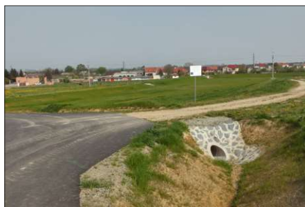
Protierozní úpravy v ulici Za Humny
